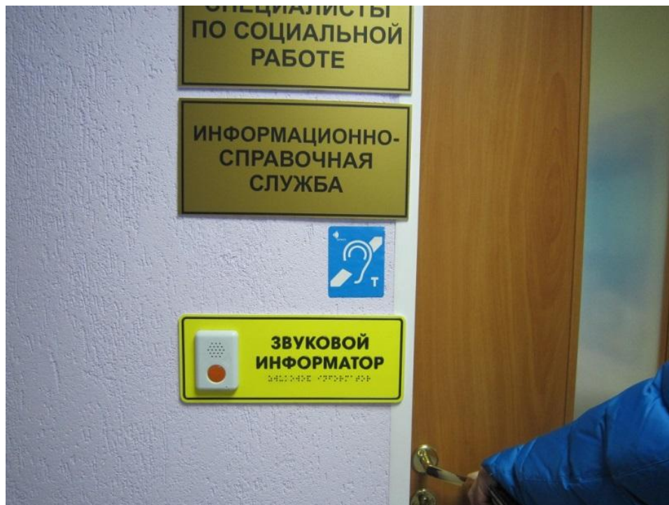
Илл. 2.9-9. Пример таблички со звуковым оповещением
