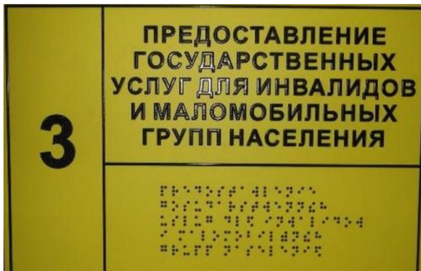
Илл. 2.9-15. Табличка с плоско-выпуклыми буквами, дублированными рельефно-точечным шрифтом Брайля
